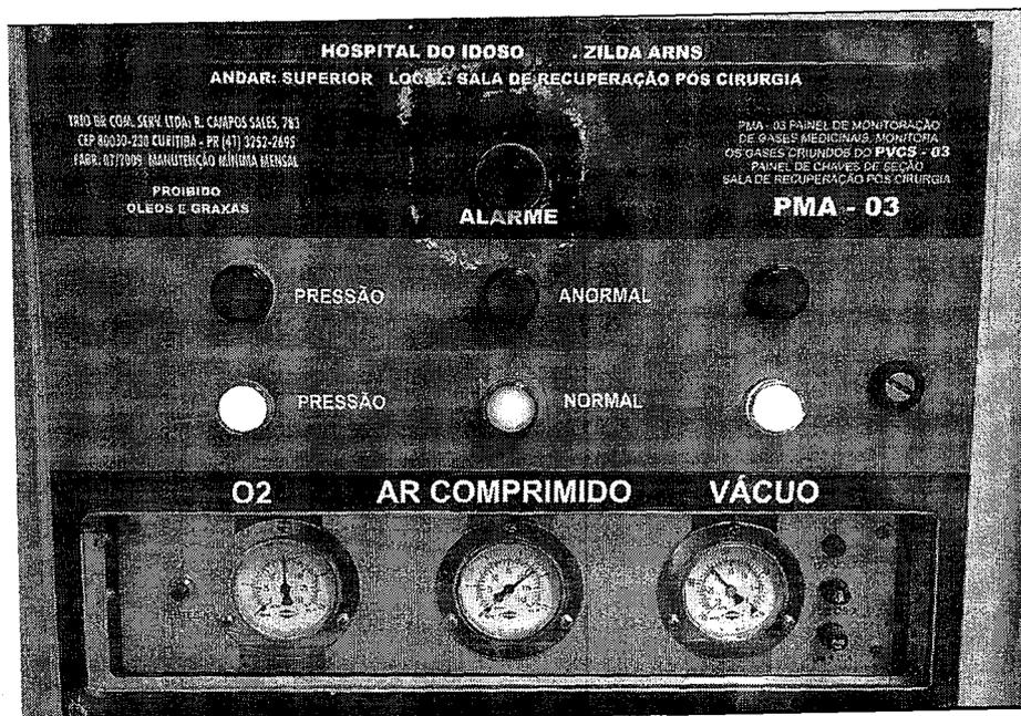
Figura 21 – PAINEL DE ALARME / MONITORAMENTO OXIGÊNIO / AR COMPRIMIDO / VÁCUO
