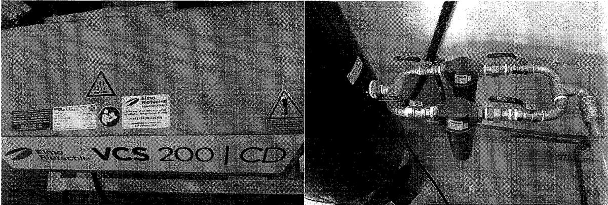
Figura 8 – BOMBA E FILTROS DO SISTEMA DE VÁCUO MEDICINAL 02 O HMIZA
