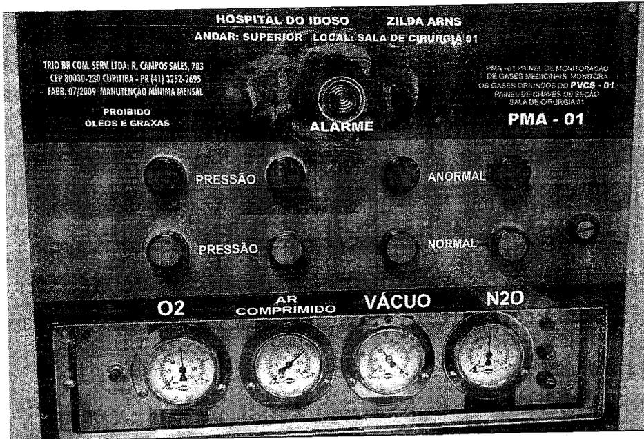
Figura 20 – PAINEL DE ALARME /MONITORAMENTO OXIGÊNIO / AR COMPRIMIDO / VÁCUO / ÓXIDO NITROSO
