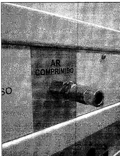
Figura 2 – ITEM 2: CONEXÃO MEDICINAL DE AR COMPRIMIDO
